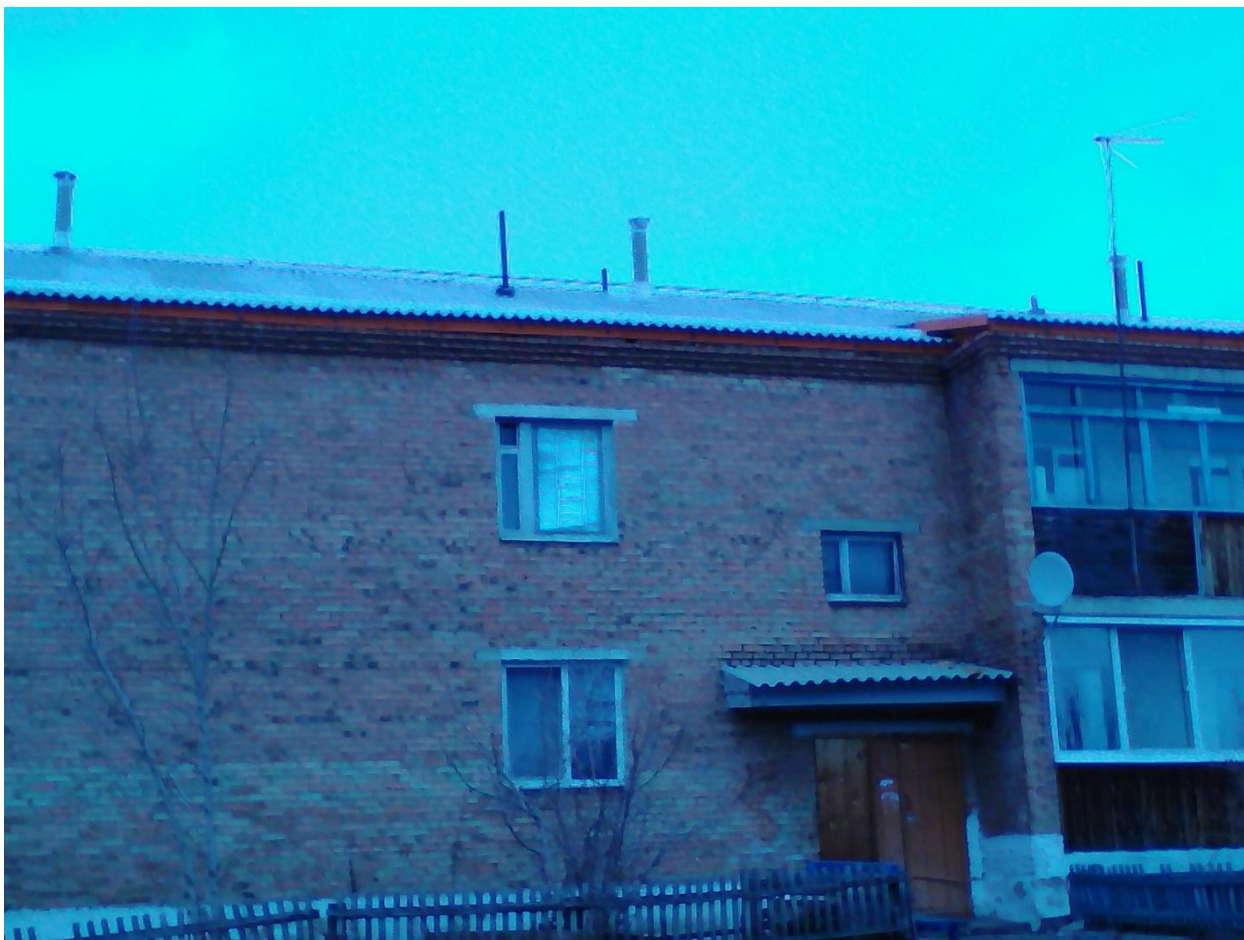
с.Сухобузимское ул.Ленина д.67 ремонт крыши
